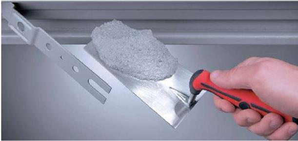
Nel caso di fissaggio con zanche, si consiglia di creare gli scassi adeguati nella parete (sezione 80 x 200 mm) oppure di fissare le zanche con tasselli. Le zanche vanno ripiegate e bloccate nella parete. Ai fini di una buona tenuta meccanica si consiglia di riempire il vuoto tra telaio e muratura con malta cementizia oppure con schiuma poliuretanica; questo riempimento è invece obbligatorio nel caso di porta per esterno marcata **CE**.
